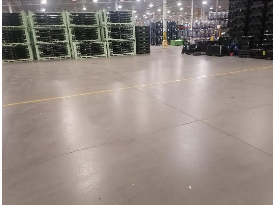
Ilustración 5. 4 Almacén Dock E. Fuente: COMPAS. 2024
